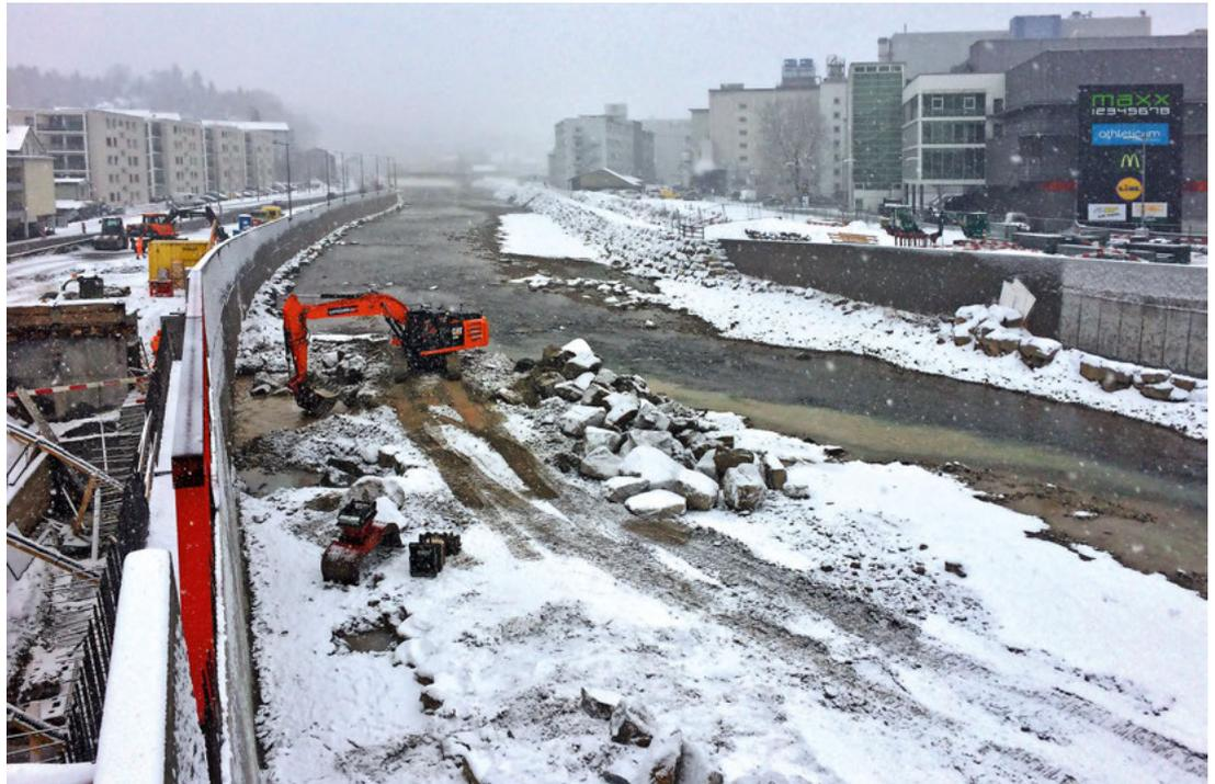
2 | Blick gegen Strom im Bereich Obere Zollhausbrücke: Verlegen des vorgelagerten Blocksatzes am 11. Januar 2017 (Foto: vif LU).
