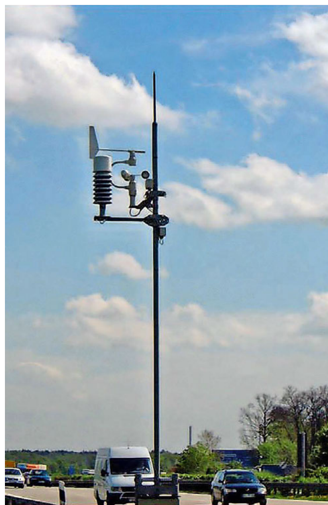
4 | Glättemeldeanlagen Fahlhorst (© KFZB).
