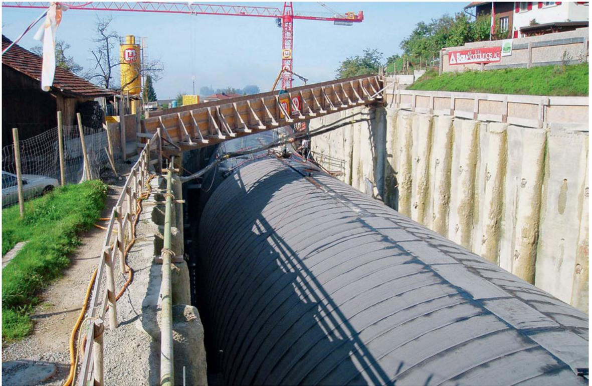
1 | Anwendung von Polymer-Bitumen-dichtungsbahnen (PBD) im Tagbautunnel (Foto: Schoellkopf AG).
