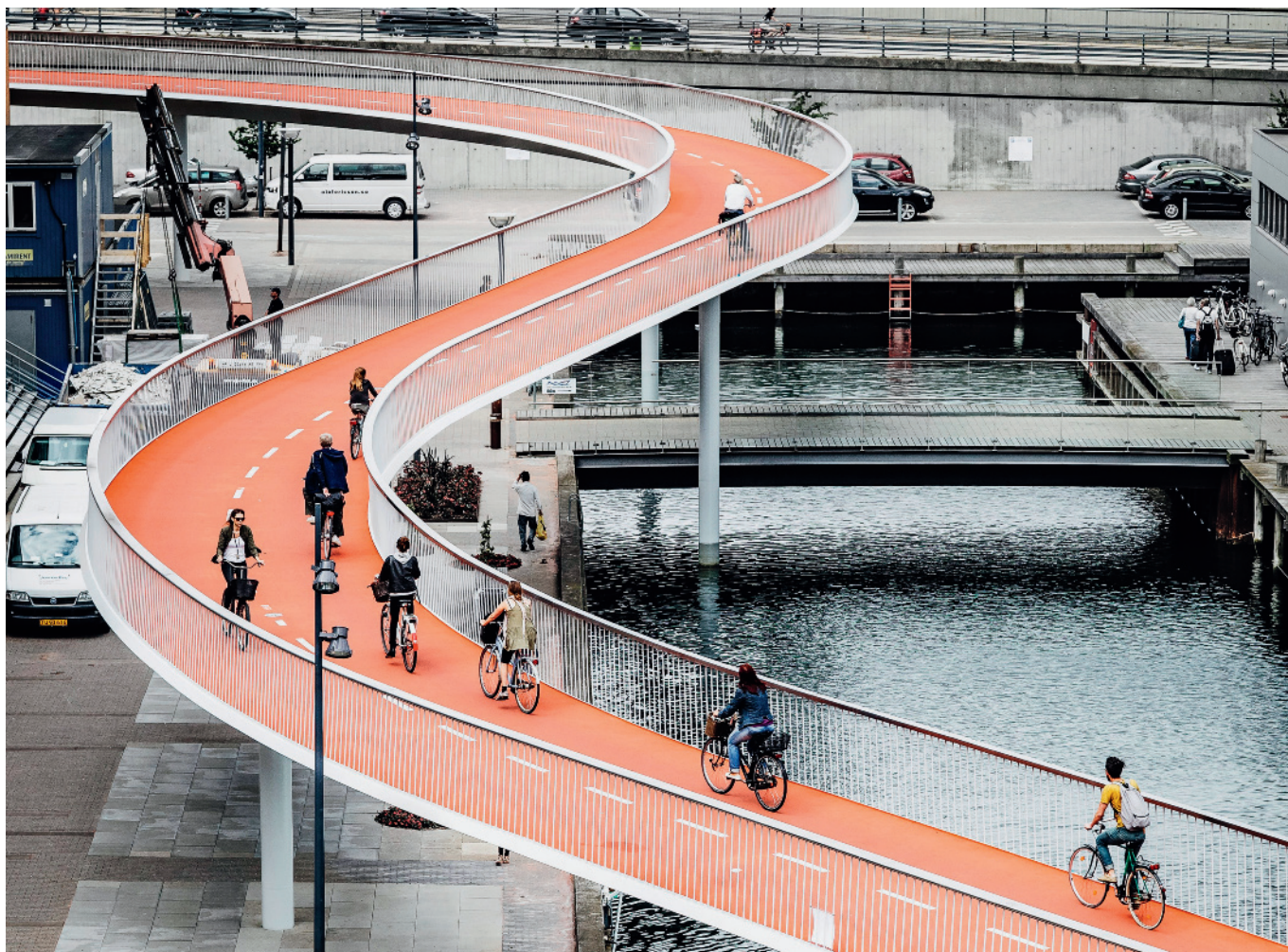
1 | Die Cykelslangen ist eine Brücke für den Veloverkehr über das innere Hafenbecken von Kopenhagen.
