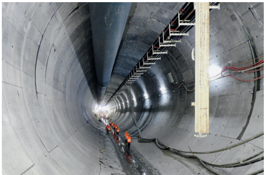
4 | Gang durch das riesige Tunnelgewölbe mit einem Innendurchmesser von über 13 m.
