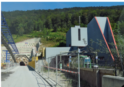
1 | Südportal direkt neben den bestehenden zwei Tunnels.
