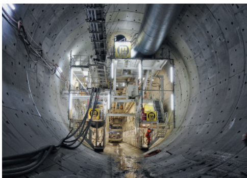
2 | Der sogenannte Nachläufer, hinter der Bohrmaschine, ein eigentliches Fabrikgebäude.
