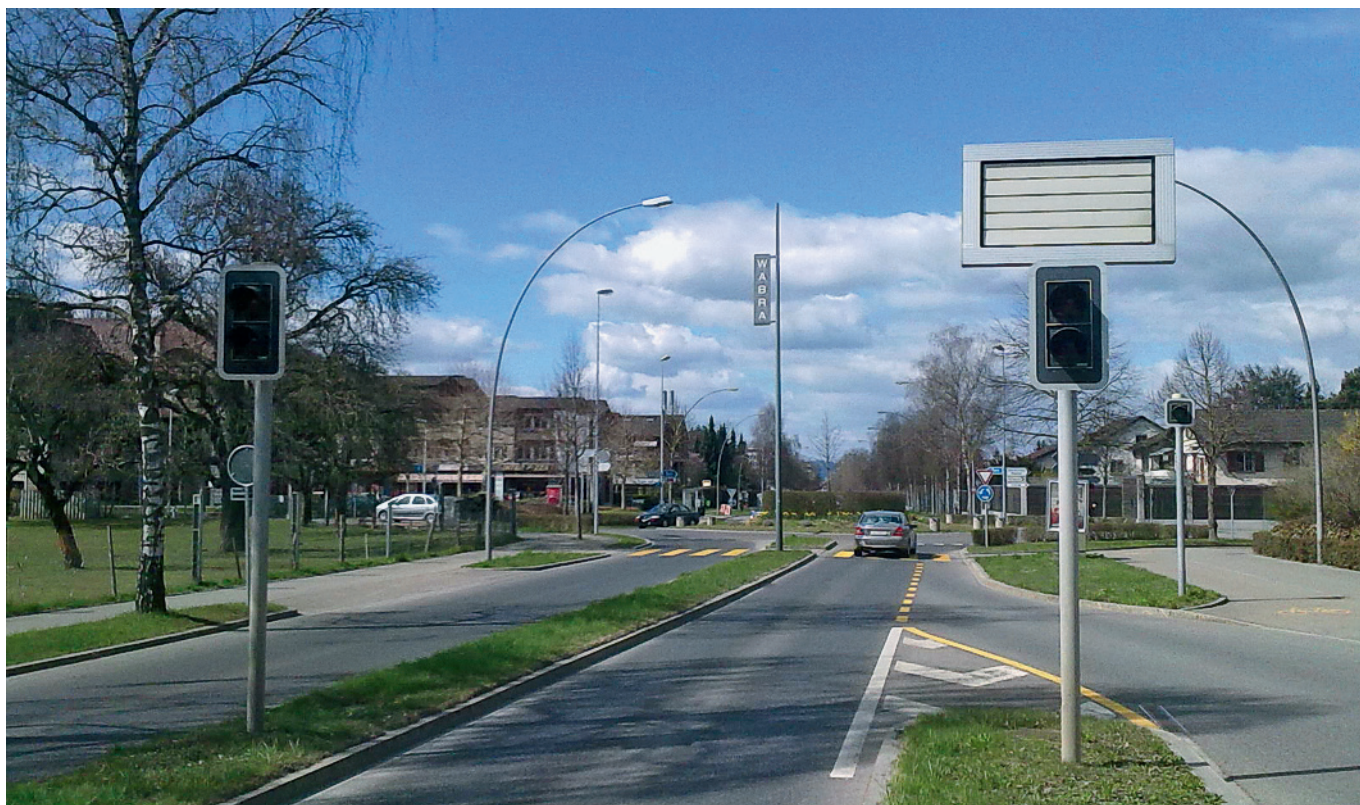
1 | Heutige Dosierungsanlage am Ortsrand von Wabern (Foto: Gruner AG). 1 | Installation de régulation actuelle à la périphérie de Wabern (photo: Gruner AG).
