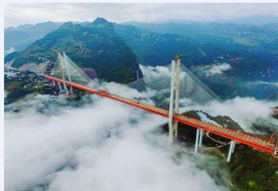
nicht. Diesen Titel trägt das Viaduc de Millau, eine 2004 im Süden Frankreichs eröffnete Autobahnbrücke. Der höchste Mast erreicht 343 Meter. Die Pylone der Beipanjiang-Brücke sind nur etwa 250 Meter hoch – sie stehen aber auch ein ganzes Stück oberhalb des Flusstals, sodass sich trotzdem eine Brückenhöhe von 565 Metern ergibt.
