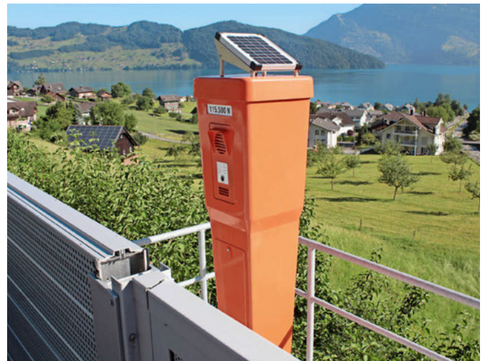
5 | Notrufsäule auf der N2 mit Solarpanel [Sauber+Gisin Engineering AG, 2017]. 5 | Borne SOS sur la N2 avec panneau solaire [Sauber+Gisin Engineering AG, 2017].
