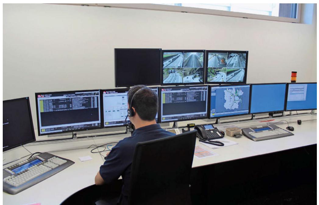
6 | Verkehrsüberwachung Gebiets-einheit Zentras. Überwachung der Daten und Bilder von der Strecke [Sauber+Gisin Engineering AG, 2017].
