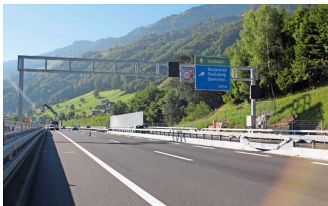
2 | Signalbrücke bei Beckenried (Sauber+Gisin Engineering AG, 2017). 2 | Portique support de panneaux près de Beckenried.
