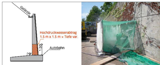
7 | Prüfmethode talseitiger Höchstdruckwasserabtrag.
