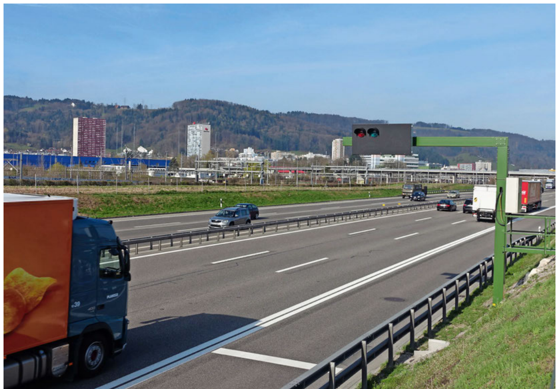
5 | Dosieranlage Anschluss Spreitenbach Richtung Bern [Saubert+Gisin Engineering AG, 2017] 5 | Installation de dosage jonction de Spreitenbach en direction de Berne.
