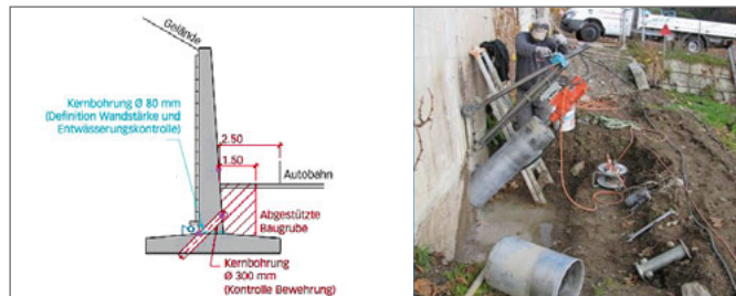
5 | Prüfmethode talseitige Sondierbohrungen.
