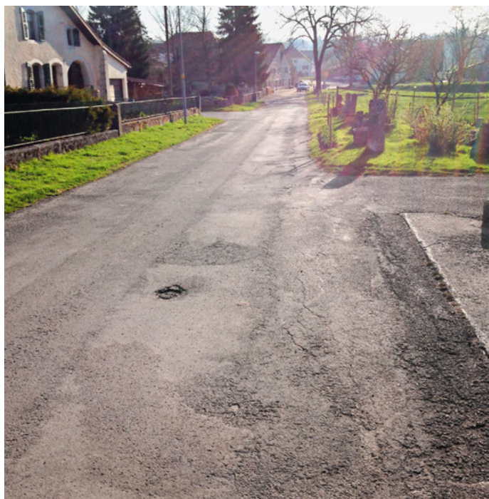
7 | Photo avant/après entretien d'un axe où la commune a opté pour la pose d'un enrobé à froid
