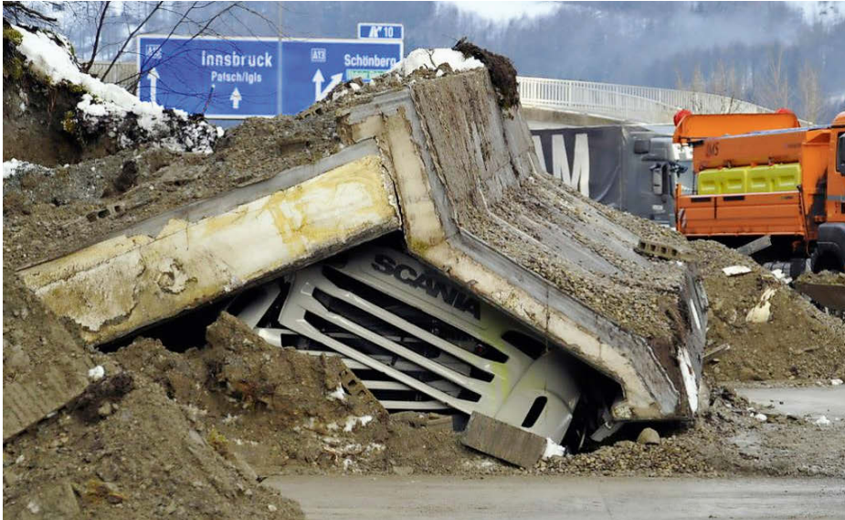
2 | Die umgestürzte Stützmauer vor der Hauptmautstelle Schönberg an der A13 Brenner-Autobahn in Österreich hat am 20. März 2012 einen Sattelschlepper unter sich begraben.
