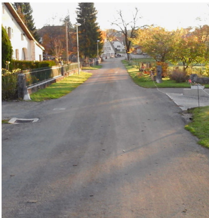
7 | Foto vor/nach Instandhaltungsmassnahmen an einer Verkehrsachse, bei denen die Gemeinde sich für den Einbau von Kaltmischgut entschieden hat.
