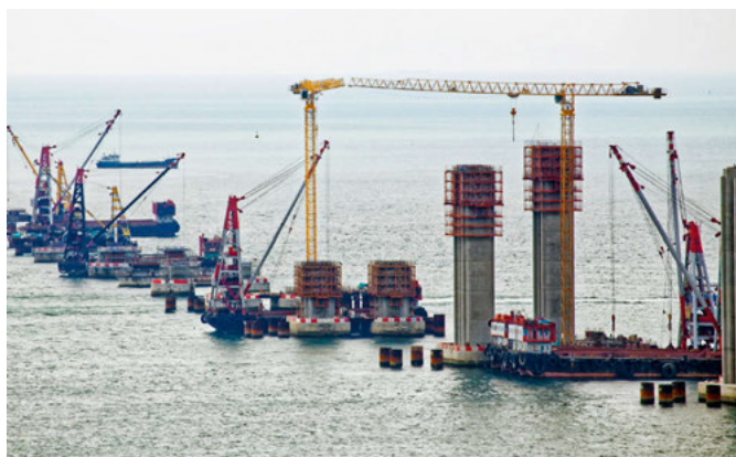
2 | An Land vorgefertigte Stelzen werden in den Meeresgrund gerammt. 2 | Les pilotis préfabriqués sur la terre ferme sont battus dans le fond marin.
