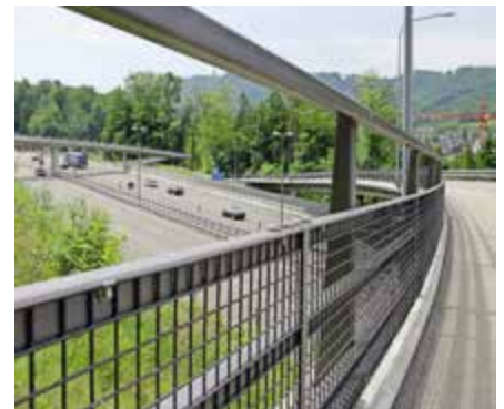
Das Lenzlinger Stahlgeländer in der Ausführung mit Übersteig- bzw. Schneeschutz auf der Überführung Butzenstrasse an der Westumfahrung Zürichs.
