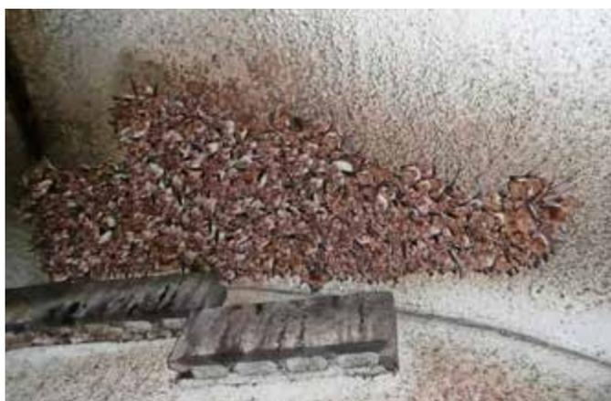
4 | Mausohrkolonie mit vierhundert Tieren im Hohlkörper der Brücke von Corbières. Der Kot von Fledermäusen verursacht keine Schäden am Beton. Bei Metall kann es aber unter Umständen zu Korrosion kommen, was mit geeigneten Massnahmen verhindert werden kann (Foto: Jérôme Gremaud).
