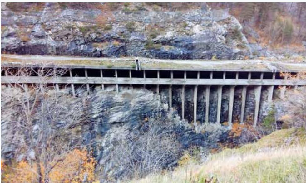
Strassengalerie zum Schutz vor Lawinen und Überflutung, darüber Steinschlagschutznetz. Aufgenommen an der Simplonpassstrasse in der Gondoschlucht.
