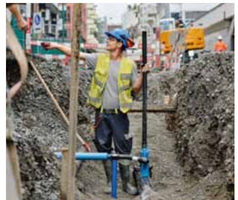
9 | ewl agierte als der Generalunternehmung zugeteilter Rohrbau-Subunternehmer (Foto: Alfons Gut).
