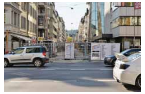
6 | Die Winkelriedstrasse war während etwas mehr als zwei Monaten gesperrt (Foto: Alfons Gut).
