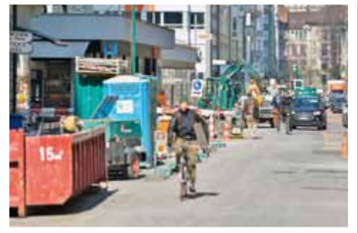
5 | Die Vorarbeiten fanden teilweise unter anforderungsreichen Bedingungen im normalen Verkehr statt (Foto: Alfons Gut).
