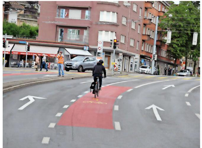
3 | Separate Linksabbiegespuren für den Radverkehr ermöglichen sicheres Abbiegen (Beispiel aus Bern)
