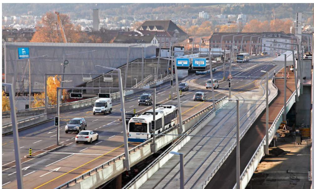
Bereich des Knotens versetzt werden, sodass ein passender Kreuzungswinkel zu den neuen Tramgleisen möglich war. Das Industriegleis ist mit sogenannten Strailplatten versehen. Sie verhindern, dass Veloreifen in das Gleis geraten und es deswegen zu Stürzen kommt.
