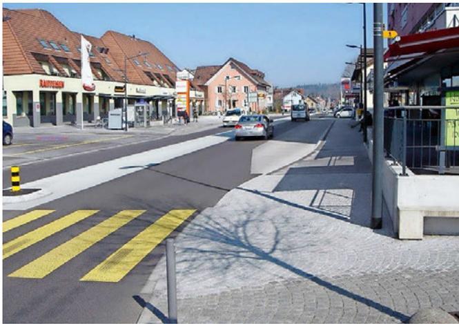
4 | Beispiel Fislisbach: Mehrzweckstreifen ermöglicht Schmalfahrbahn.
