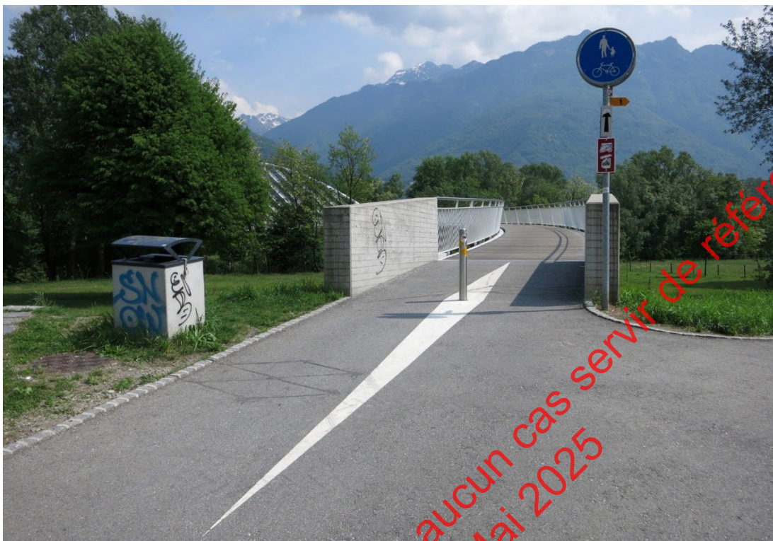
Fig. 24 Exemple de marquage au droit d'un potelet
